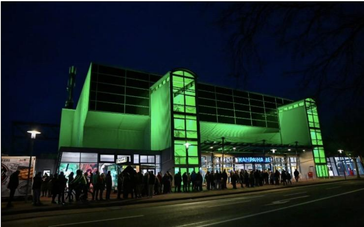
Die KAMPA-HALLE am Abend des Neustarts, nach der fast dreijährigen Renovierung, am 14. Februar 2026
